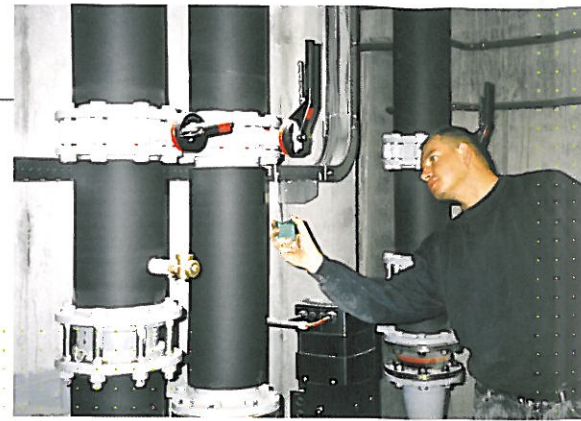
Gerade bei Kühlwasserleitungen von Klimaanlage ist ein sehr hohes Energieeinsparpotenzial vorhanden.
